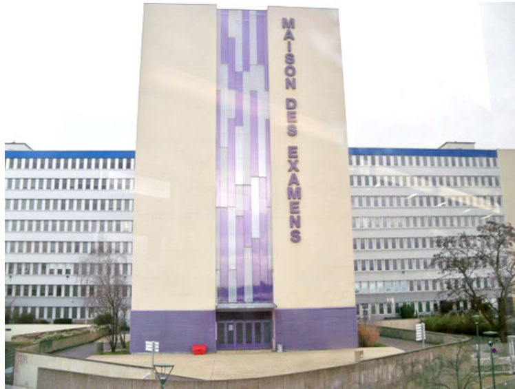
La Maison des Examens, Arcueil
