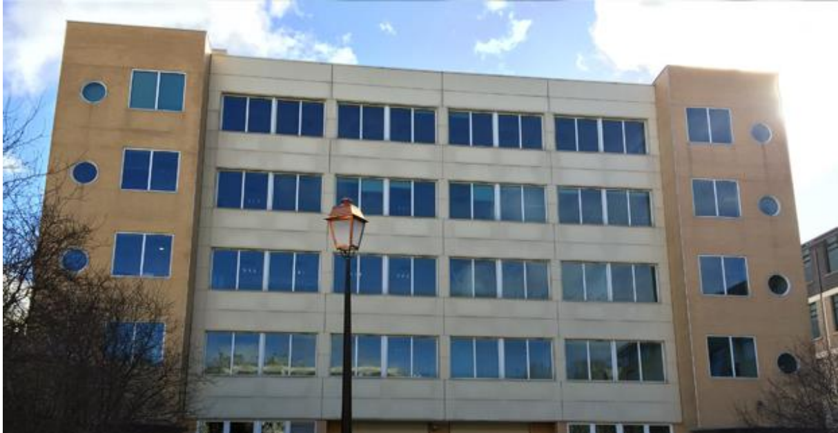
Le nouveau centre de formation de l'IFRAC à Montrouge.
